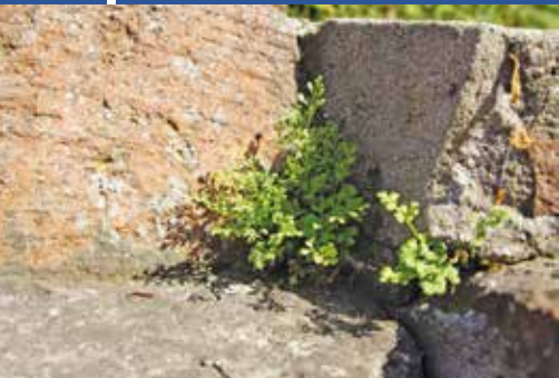
▲ ..... Zankocica murowa (DS)
